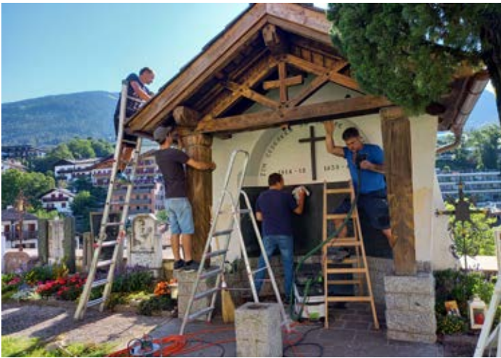
Schützen bei der Sanierung des Kriegerdenkmals ...
