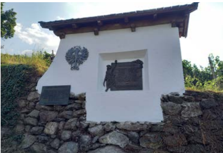
... und das frisch sanierte Denkmal im Sticklen Gassl.
